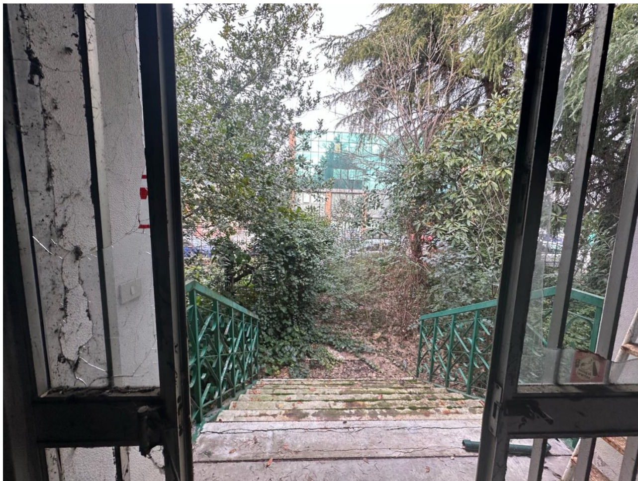
Ingresso da via Fucini (vista dall'interno).
