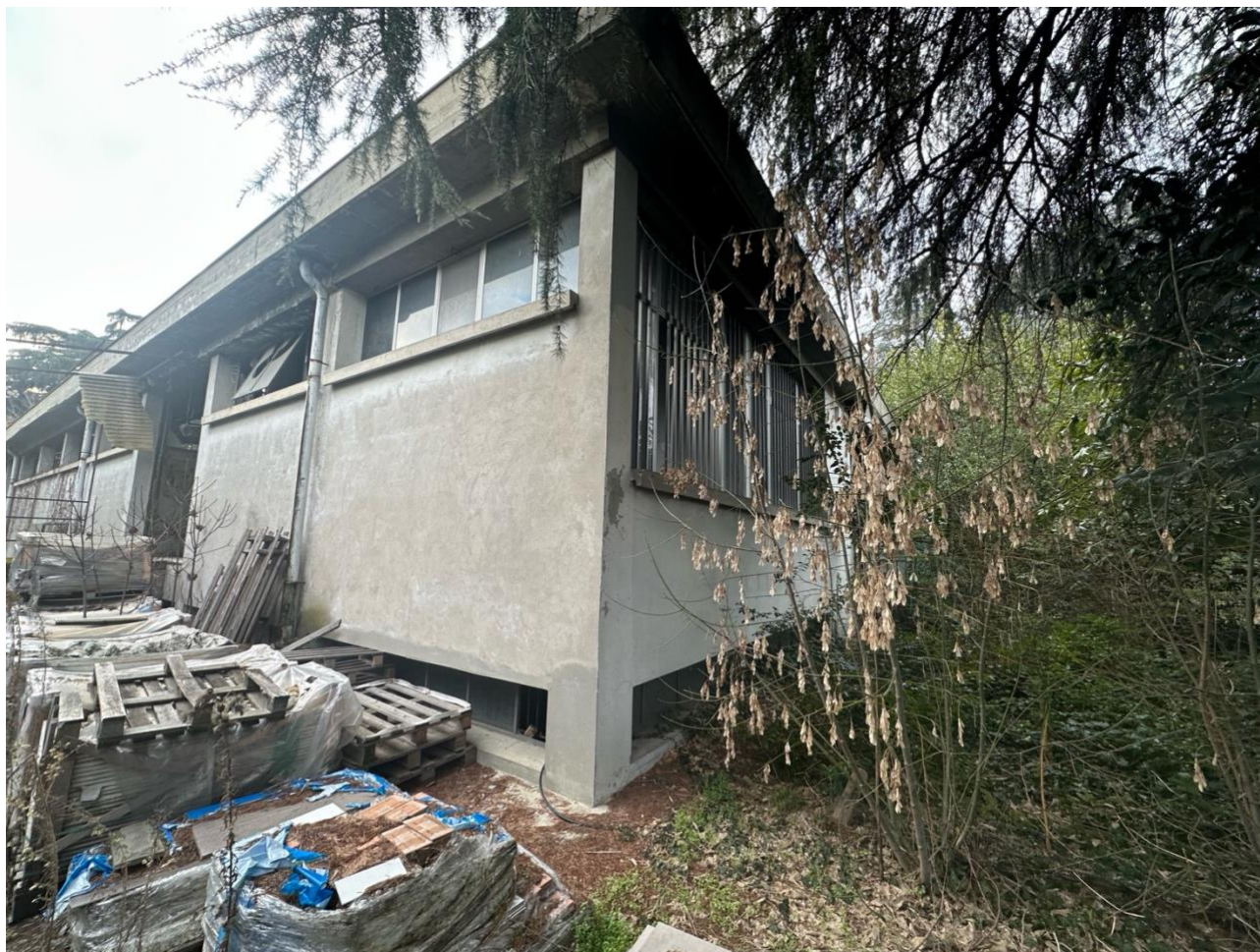
Esterno Capannone, con zona cortiliva ingombra di materiali vari.
